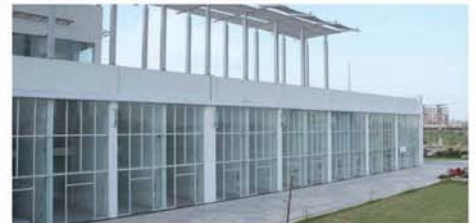
Actual Site Photographs
